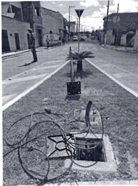
INSTALAÇÕES DAS FIAÇÕES ELETRICAS
