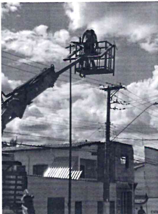
INSTALAÇÕES DAS LUMINARIAS DE LED COM RELÉ
