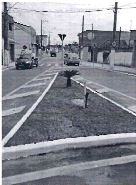
CANTEIRO FINALIZADO COM GRAMA E PINTURA
