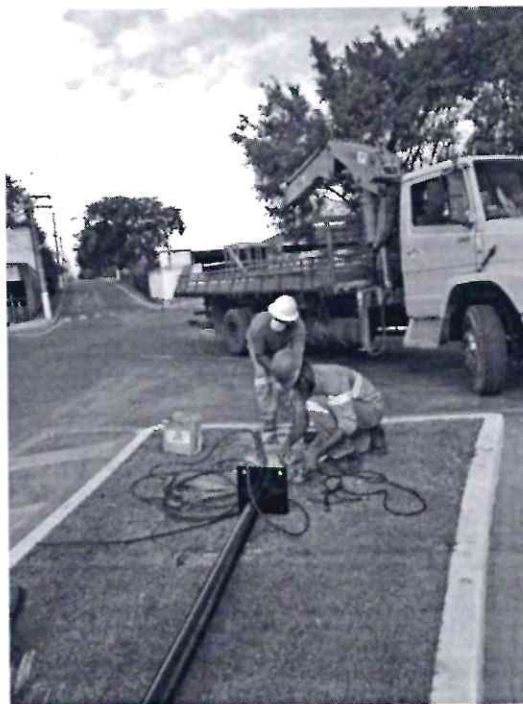
INSTALAÇÕES DAS FIAÇÕES ELETRICAS
