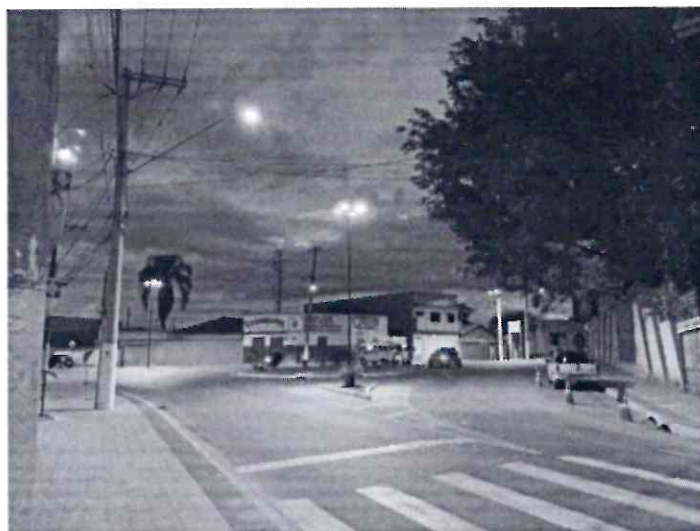
ILUMINAÇÃO ELETRICA FINALIZADA
