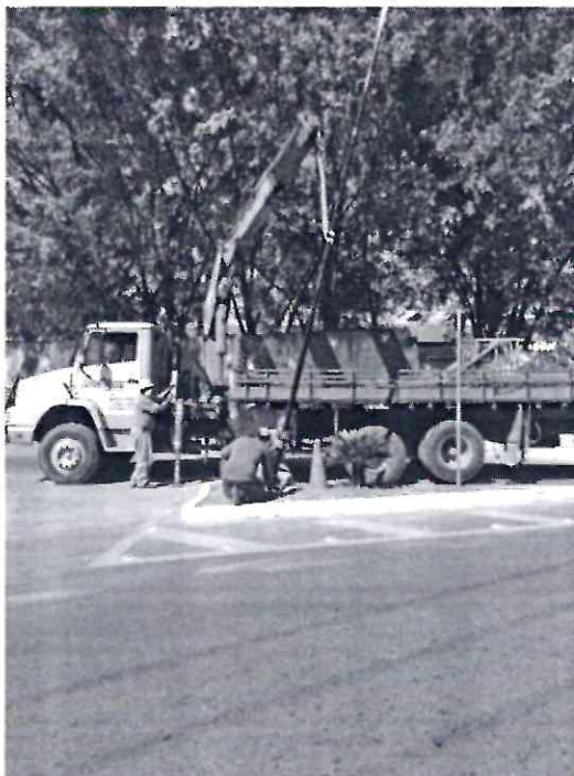
INSTALAÇÃO DOS POSTES DE ILUMINAÇÃO
