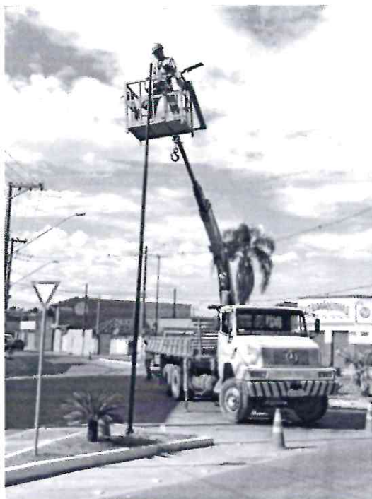
INSTALAÇÃO DOS SUPORTES E CRUZETAS
