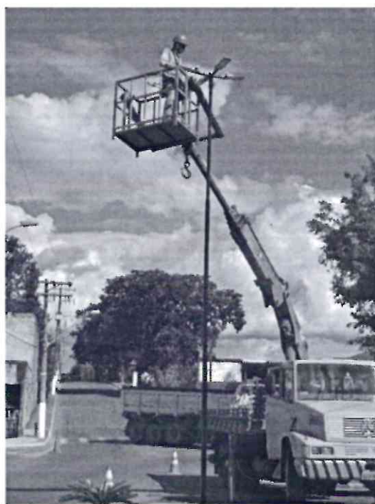
INSTALAÇÕES DAS LUMINARIAS DE LED COM RELÉ
