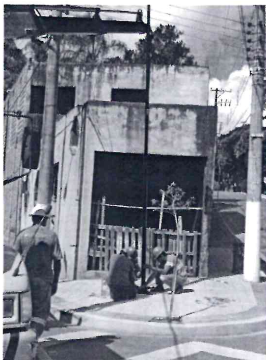
INSTALAÇÃO DOS POSTES DE ILUMINAÇÃO
