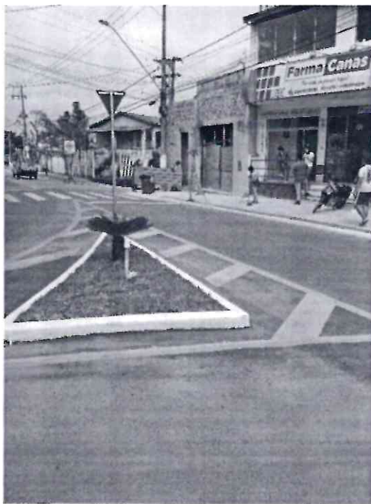
CANTEIRO FINALIZADO COM GRAMA E PINTURA
