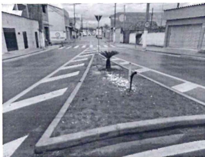
CANTEIRO COM GUIAS EXECUTADAS E ATERRADO
