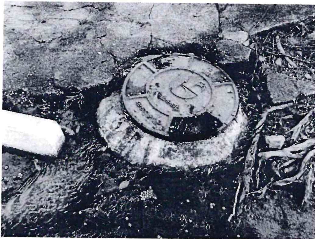
Foto 4 – Vazamento do Poço de Visita
