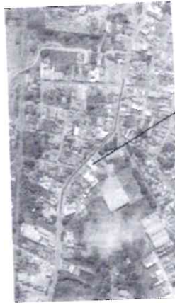
LOCALIZAÇÃO - VISTA AEREA LAT. 22°42'16.97\"/>
